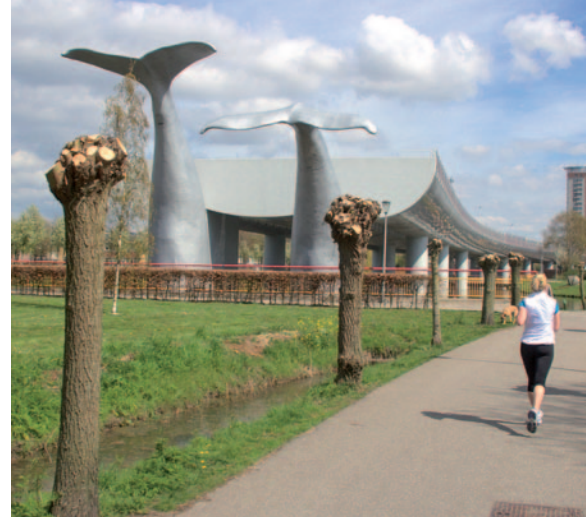
De twee walvisstaarten van metrostation De Akkers in Spijkenisse, beginpunt van de Rotterdamse metro. WIKIPEDIA
